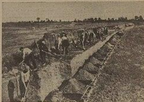
Maasverbetering.... Arbeiders in werkverschaffing graven in een doorleiding.
